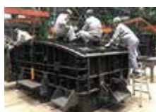
インバート型枠組立・空中反転機
