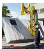
インバート型枠組立・空中反転機
